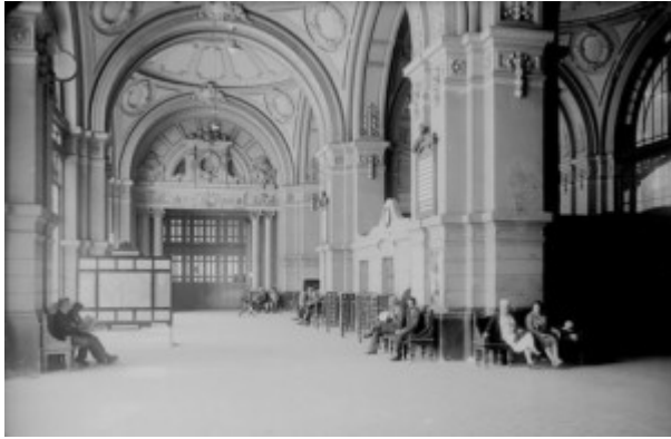
1930, Hall de acceso a la Estación, sector de boletería y sala de espera de pasajeros. Fuente: Centro Cultural Estación Mapocho
