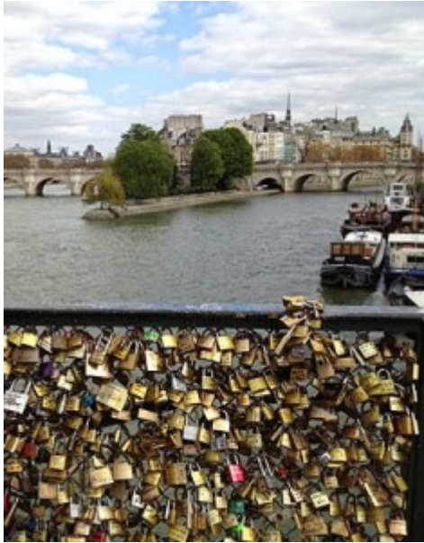
La actual vista del Pont des Arts, en París. El principal puente afectado.
